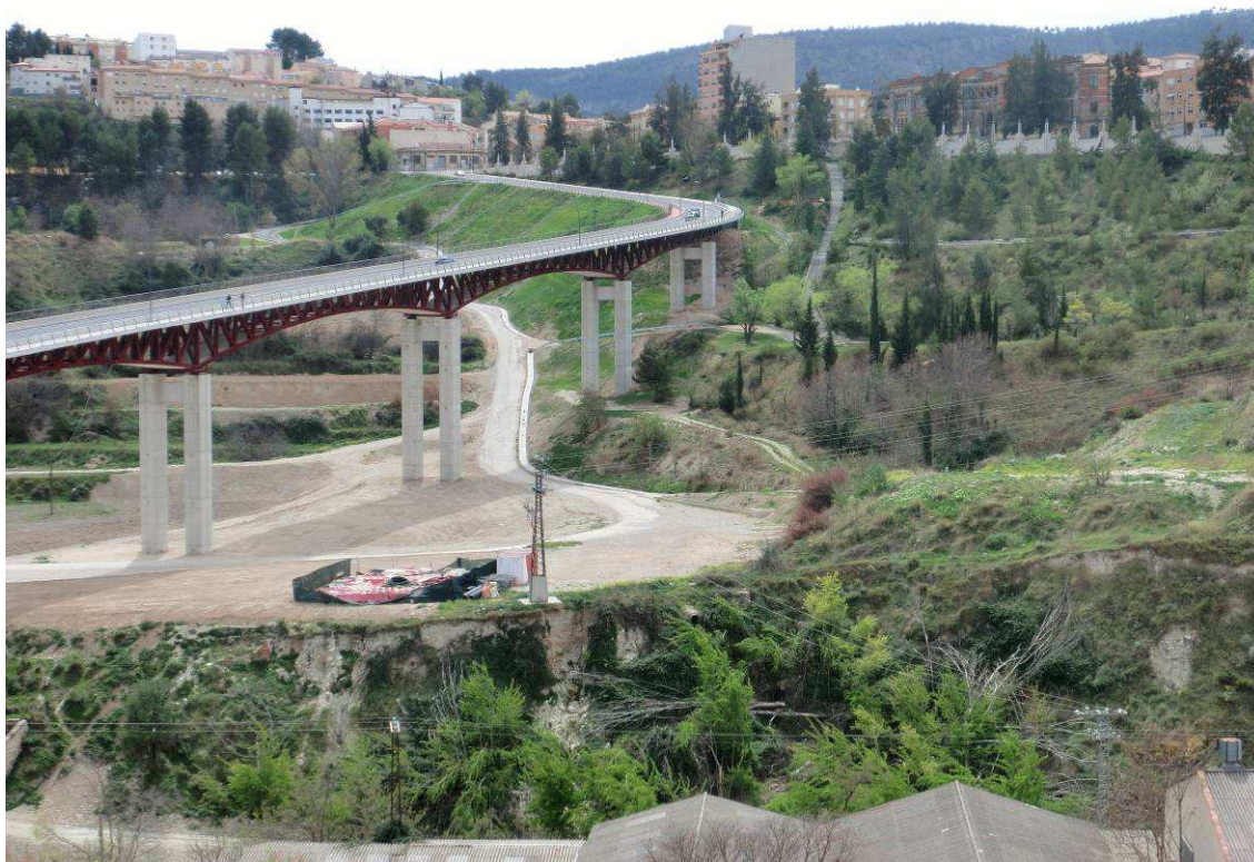
Nuevo acceso a la zona del Viaducto: puente Francisco Aura.
