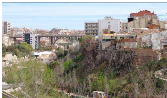
Fachadas del centro urbano recayentes a cauce.
