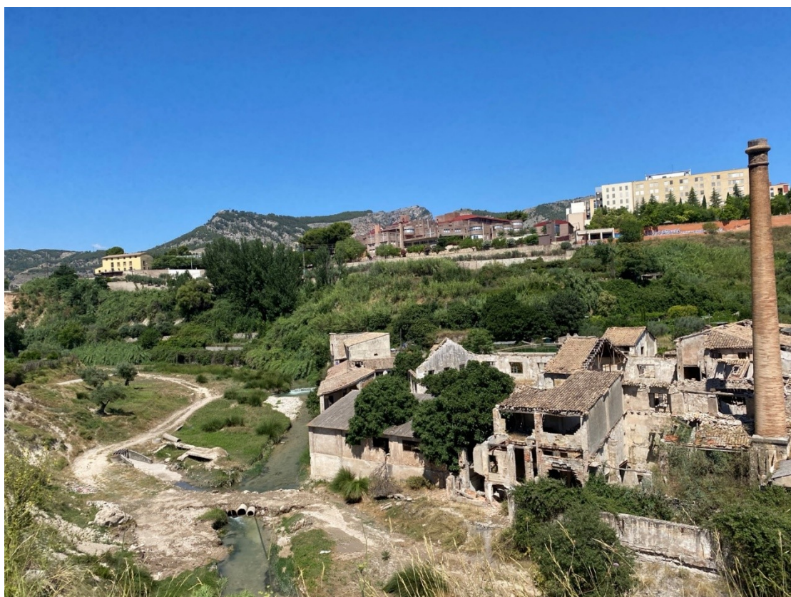
Imagen fábricas abandonadas en el cauce del río Serpis. Fuente: Inteligencia Climática 08/julio/2022
