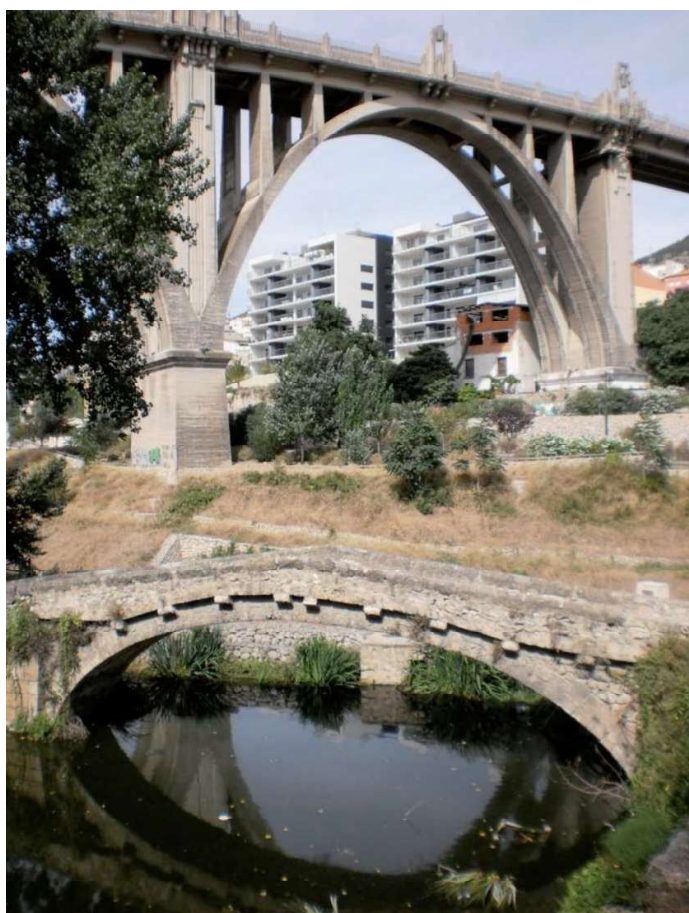
Puente de Buidaoli, en primer término, y Puente de Sant Jordi –construido en 1931– ambos sobre el Río Riquer. (Autores: Ponce y Moltó)
